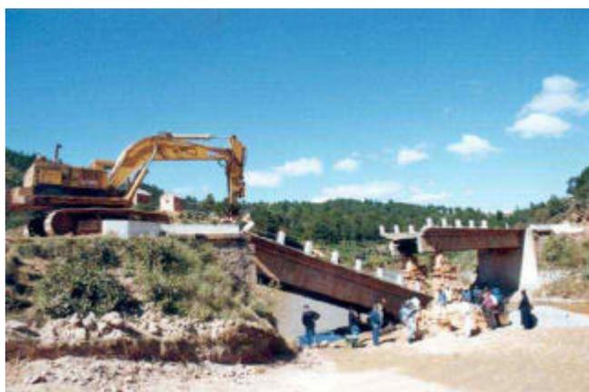
Photo – 2 : Reconstruction de la partie détruite - soulèvement par vérinage
