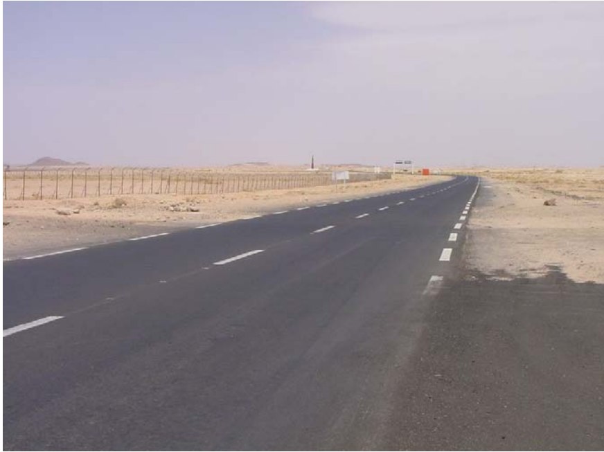
Figure 12 : Route transsaharienne à Tamanrasset aérodrome : Couche de base en arène granitique
