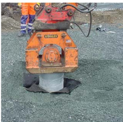
Figure 3. – Installation du tube en acier
