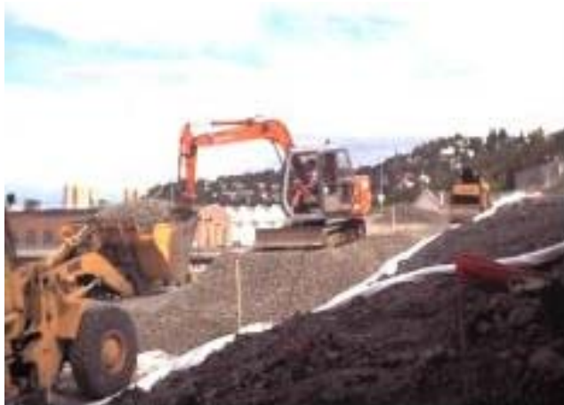
Figure 4 – Distribution du verre cellulaire utilisant une pelle montée sur chenilles / boteur
