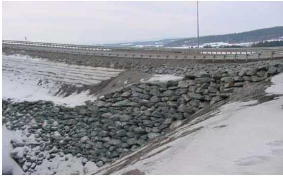
Figure 9 – Pentes en verre cellulaire exposé
