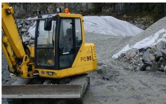
Figure 11- Compactage léger du remblai de la route de diversion à Klemetsrud
