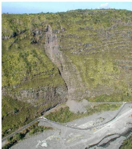
Figure 8 : Évitement d'un éboulement actif de 10 000 m 3 (R.N. 5, route de Cilaos)
