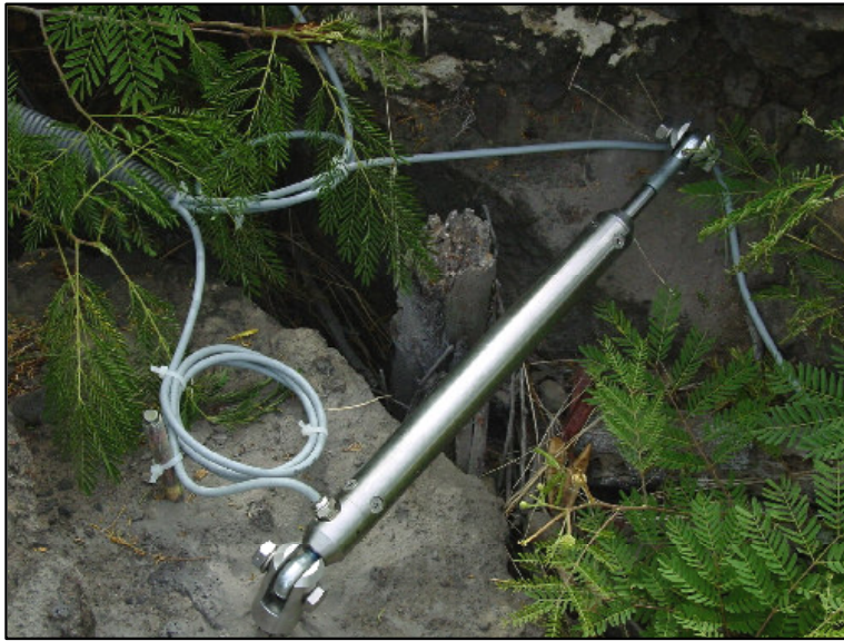
Figure 5 – Extensomètre en crête du Cap Champagne
