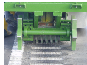
Photo n°6 Fraisage de rainures étroites
