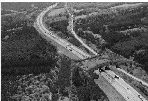
Fig. 2 – Pont paysager (Crédit photographique : Luchtfotografie Slagboom en Peeters) et passage inférieur (Crédit photographique : B. Iuell).
