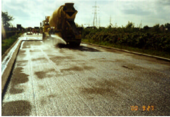
Figure 5 : Humidifier la surface asphaltée juste avant de bétonner.
