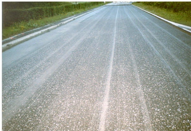
Figure 2 : Surface asphaltée après fraisage
