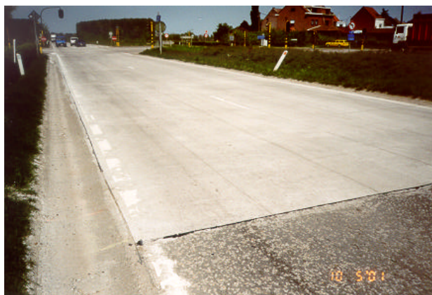
Figure 8 : Aspect du revêtement en UTW
