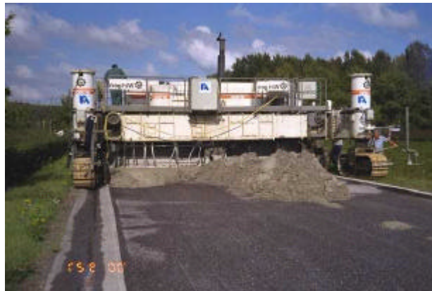
Figure 6 : Exécution à l'aide d'une machine à coffrages glissants
