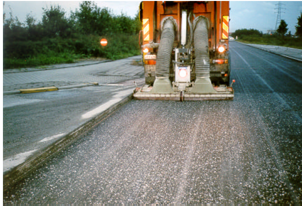
Figure 3 : Nettoyage de la surface fraisée à haute pression
