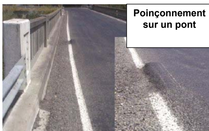
Figure 2 – Cisaillement en surface de la couche de surface observée sur une route nationale
