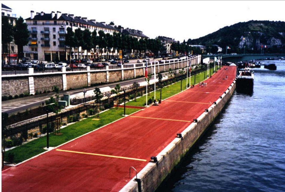
Figure 1 : ECF rouge appliqué en 2000 sur les quais de la Seine à Rouen
