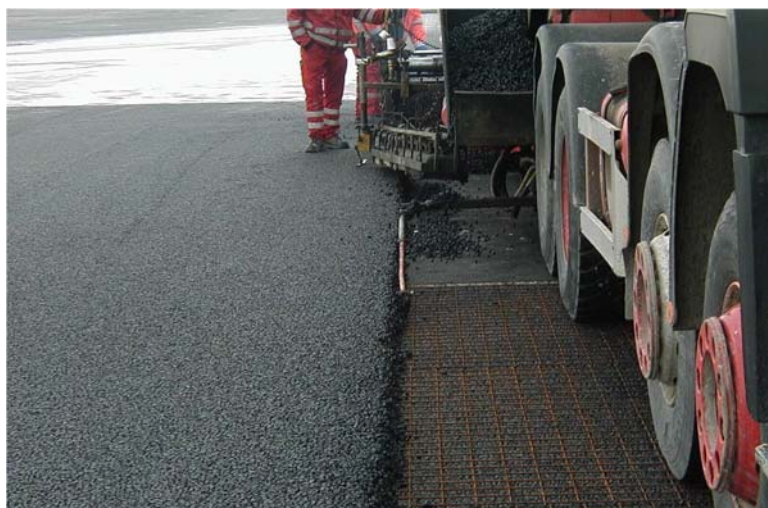
Figure 3 Pose d'asphalte ouvert sur le treilarmé en acier
