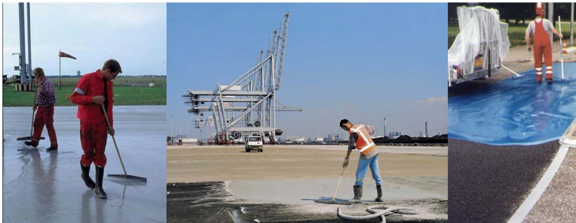
Figure 4 Épandage de mortier microsilice sur de l'asphalte ouvert, (Densit A/S, 2000).
