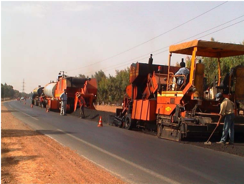
Figure 3 – Atelier de retraitement en place NOVACOL (COLAS)
