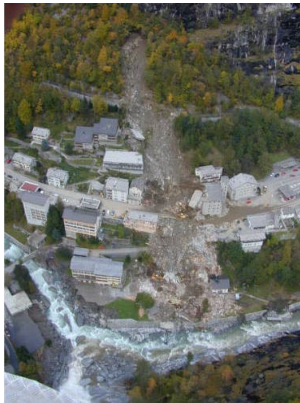
Figure 5 : Coulée boueuse détruisant le village de Gondo et la route du Simplon. Les maisons et la route ont été emportées par une coulée boueuse qui a fait glisser à son tour un mur de soutènement dans le haut du village. Photo CREAL
